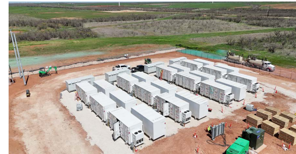
북미 협력회사와 협업을 통해 설치 중인 Texas 지역 내 50MWh의 Reuse ESS
